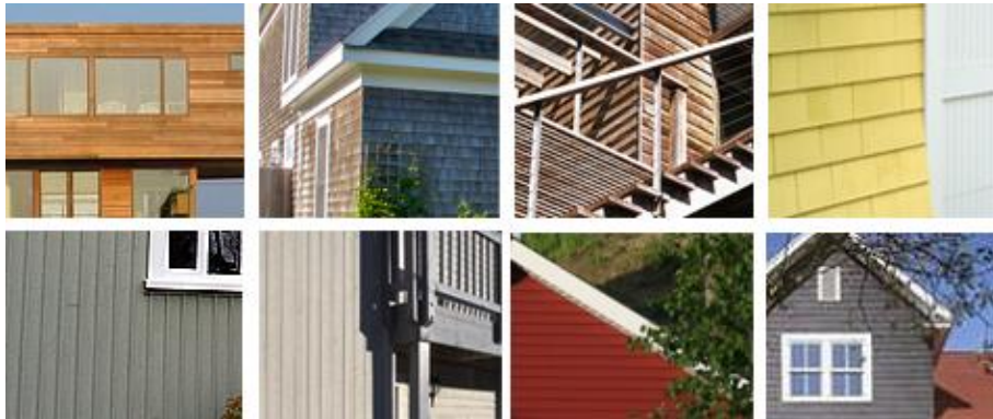
Figure 1 : Exemples de revêtements extérieurs en bois
